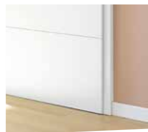
Sockelleistenanschluss durch 22 mm Bekleidung
